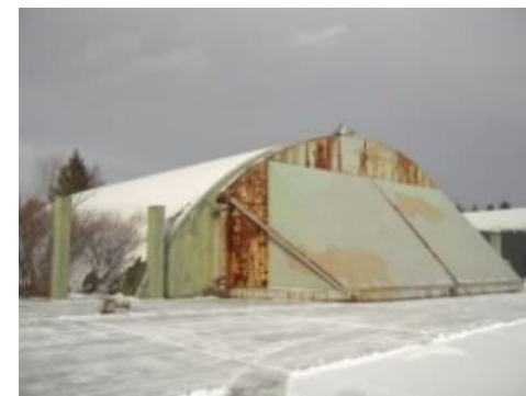
空自千歳基地 掩体(飛行場施設) (昭和58年建設)
