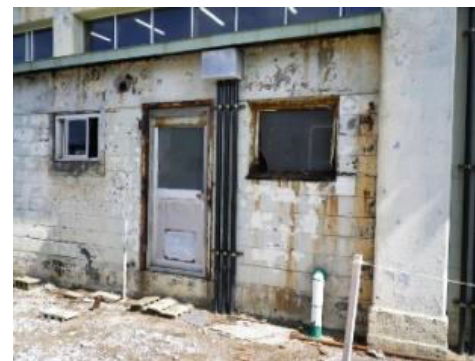
空自稚内分屯地 (車両整備工場) (昭和29年建設)
