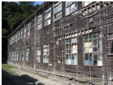
陸自久里浜駐屯地(倉庫) (昭和17年建設)
