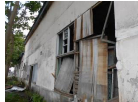
陸自神町駐屯地(倉庫) (昭和22年建設)
